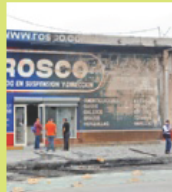
La refaccionaria frente a la zona de la explosión registró daños en la fachada.
